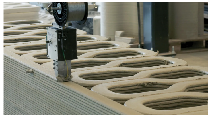
Foto: 3D-Betonprinten - Bouwmaat
