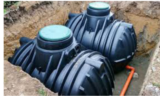
Foto: H 2 O waternetwerk - Installering van een IBA
